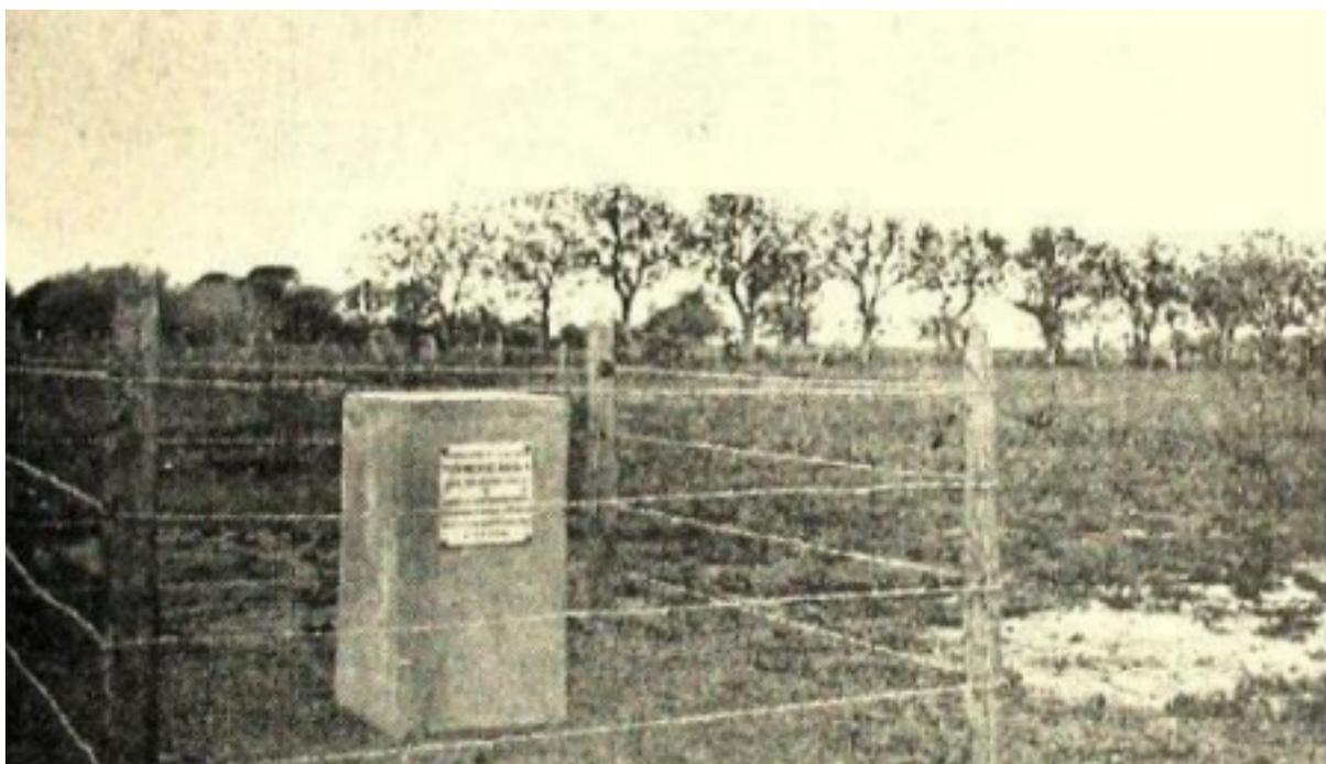
*Pilar del Punto Geodésico de la Estación
