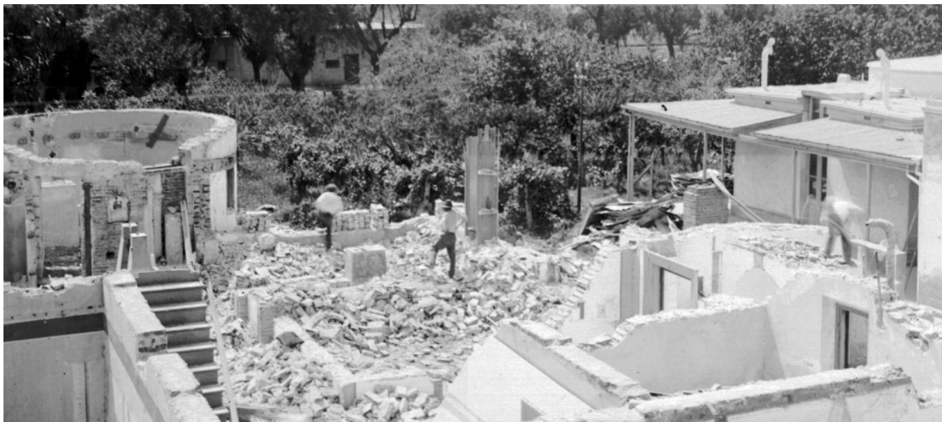
La demolición de la vieja sede del observatorio ya muy avanzada. Fuente: Archivo OAC.
