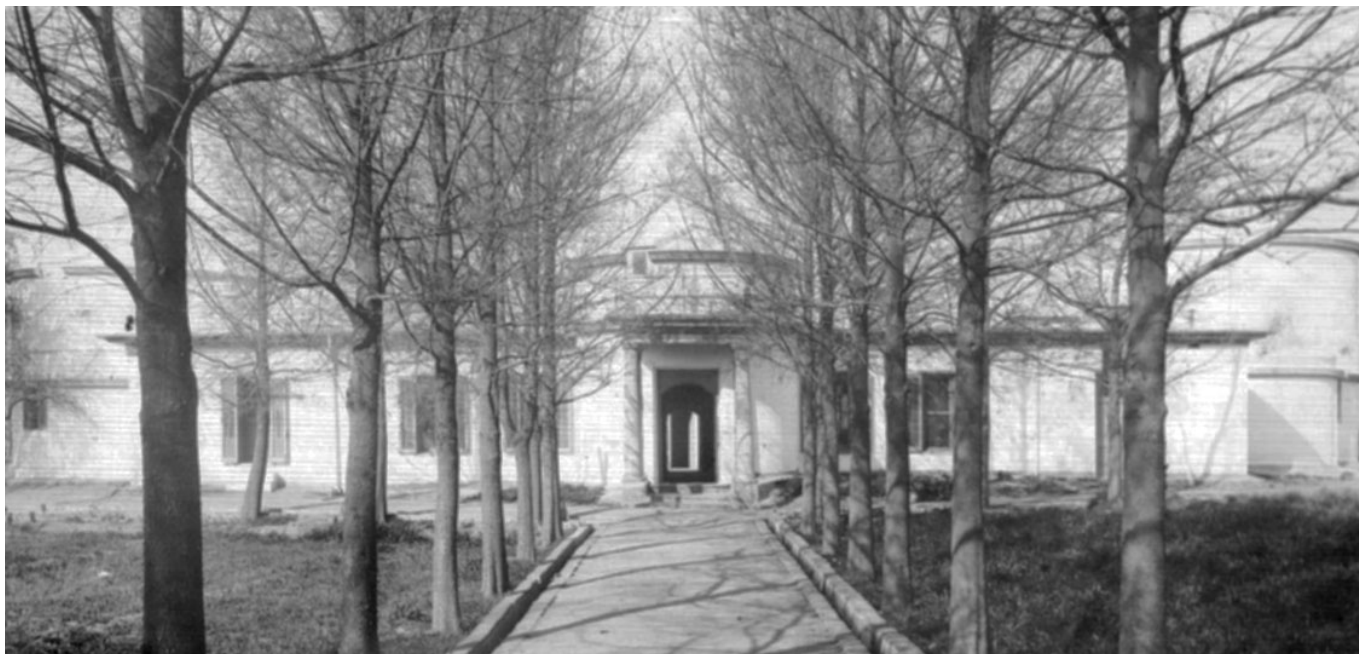
El Observatorio Nacional Argentino en la época en que Robert Winter se incorporó al mismo. Fachada norte. Fuente: Archivo OAC.
