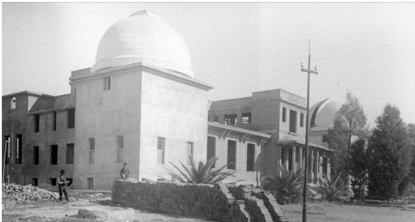
Fotografía de la esquina noroeste del edificio en 1927; la construcción se encontraba paralizada. Fuente: Archivo OAC.
