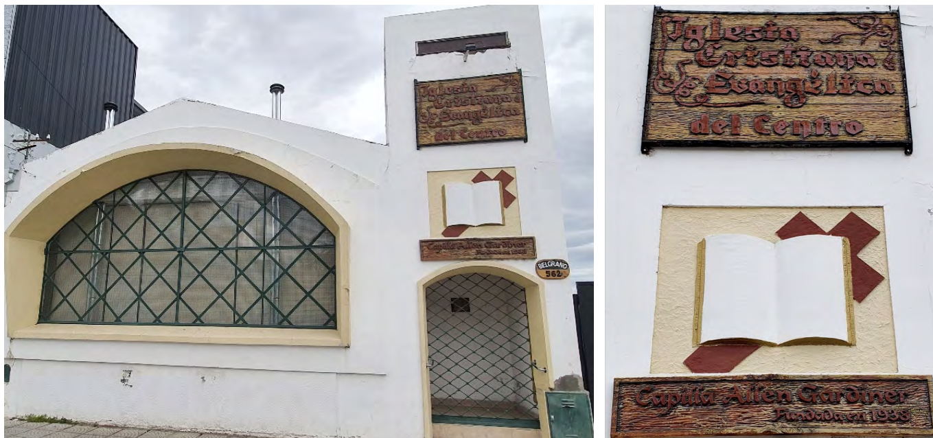
Capilla “Allen Gardiner”, ubicada en el centro de Esquel (izquierda). Detalle de la fachada (derecha). Fuente: de los Autores.
