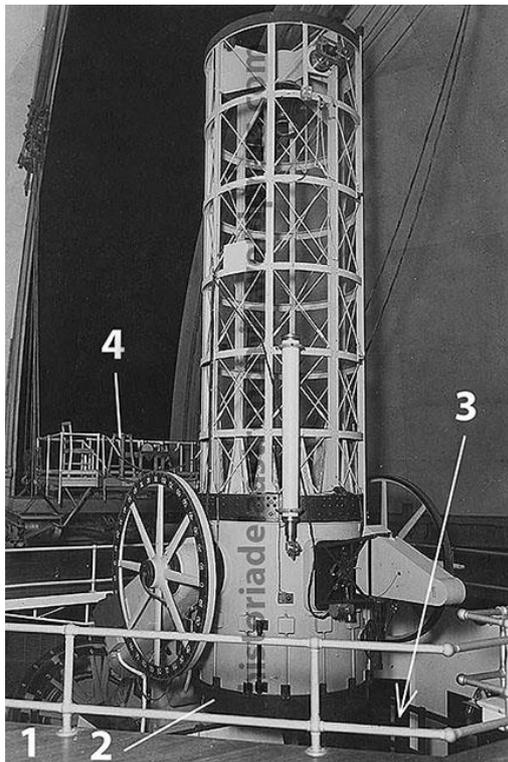
Reflector de 1,5 m la Estación Astrofísica de Bosque Alegre, fotografía obtenida aproximadamente en la época del aluminizado. (1) Tercer nivel – nivel de cúpula –, (2) celda porta espejo objetivo, (3) segundo nivel, (4) plataforma para la observación en el foco newtoniano del telescopio, utilizada como grúa para el movimiento de la celda y el espejo durante el aluminizado (Archivo OAC, dig. S. Paolantonio).
