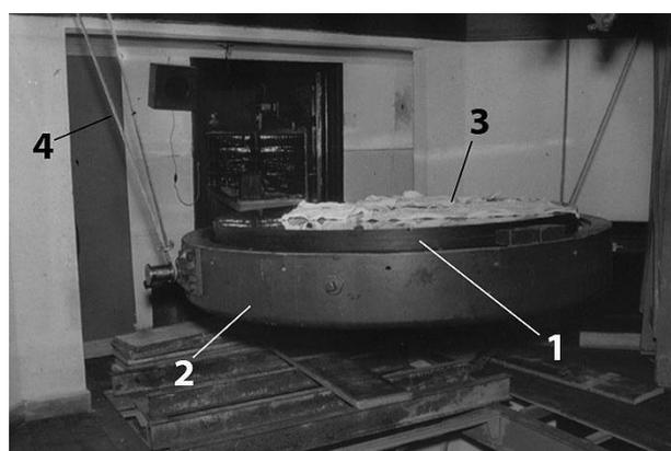
Secado de la superficie del espejo, se emplearon servilletas de tela que no dejaban pelusas (3). (1) Espejo, (2) celda porta espejo, (4) cables de acero de la grúa de la plataforma con la que se movió el conjunto durante el proceso de aluminizado. El nivel mostrado es el segundo (Archivo OAC, dig. S. Paolantonio).
