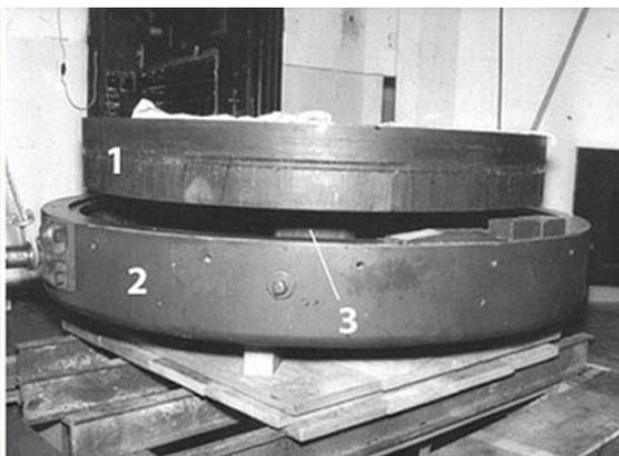
Una vez seco el espejo (1) es extraído de la celda (2) mediante un cilindro de madera (3) – imagen de la izquierda – que se introduce por un orificio central que posee la celda. Puede apreciarse en el borde del espejo una ranura, necesaria para colocar el anillo de chapa con el que se lo mueve (Archivo OAC, dig. S. Paolantonio).
