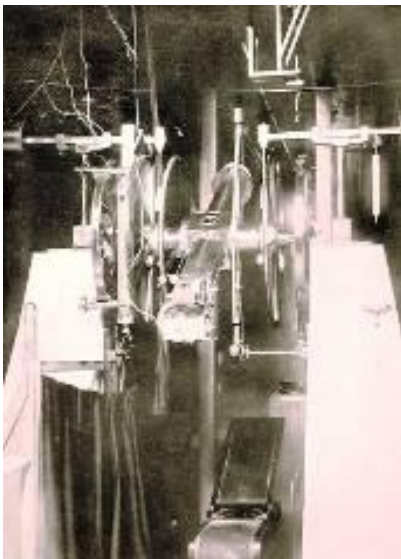
Círculo meridiano Repsold de 190 mm de apertura y espectrógrafo construido en el OAC - OAC.
