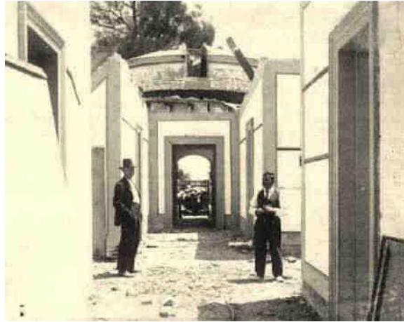
Fotografía del pasillo interior durante la demolición del viejo edificio en 1923.
