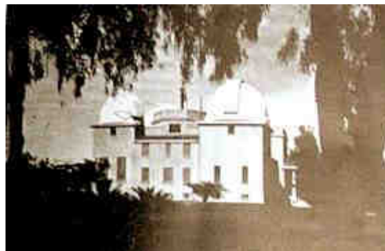
Vista lateral del Observatorio, matriz inicial de físicos en Córdoba.
