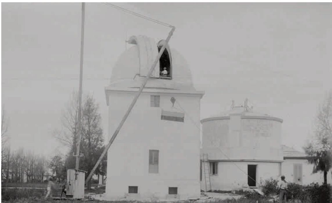
**52.** Inmediatamente después de terminada la torre noroeste se inició el montaje del astrográfico. La imagen (tomada el 2/2/1914) muestra el levantamiento con una rudimentaria grúa, de uno de los dos sectores de los que están compuestos los brazos del yugo. A la derecha la vieja cúpula donde estaba instalado anteriormente el telescopio (*Archivo OAC, digitalizada S. Paolantonio*).
