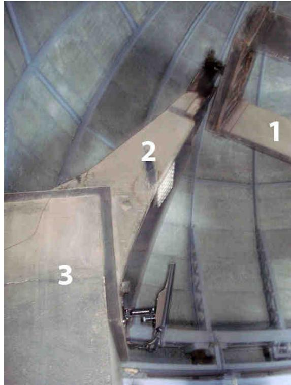
**46.** Pilar sur. (1) Yugo, (2) soporte metálico del extremo sur del eje polar; (3) pilar de hormigón (Foto S. Paolantonio, 2011).
