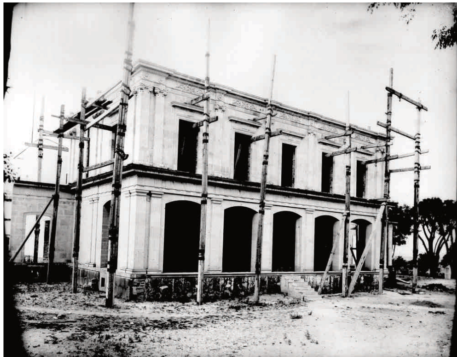
Edificio en Tacubaya en las obras que duraron 17 años.
