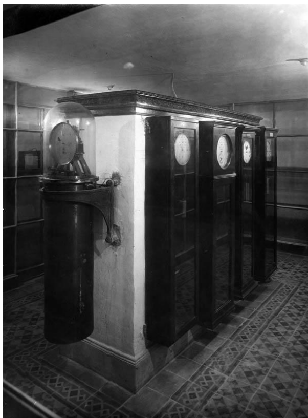
11. Conjunto de relojes a péndulo ubicados en un subsuelo, destinados al servicio de la hora. ( Biblioteca OAC )
