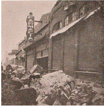
San Juan - Calle Gral. Hacha casi Santa Fe – 16-1-44 (Rusconi)
