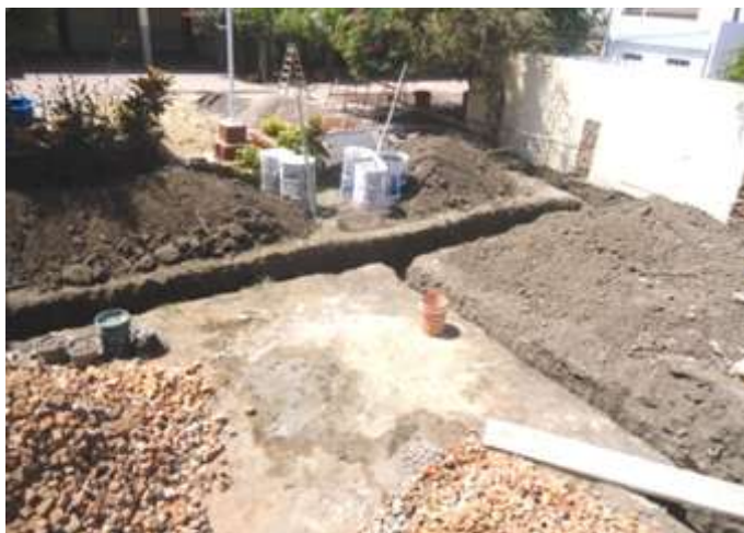
Parte de las excavaciones realizadas - Web
